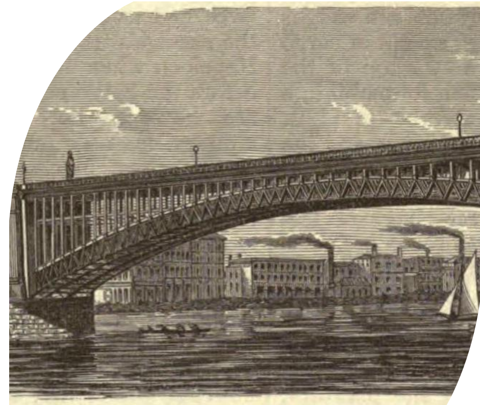
Ponte ferroviária St. Louis controlada pela Terminal Railroad Assoc. Caso “ United States vs Terminal Railroad Assoc. ”, em 1912
